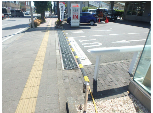
車道を横断して連送耐圧大丈夫Vホース安全養生
