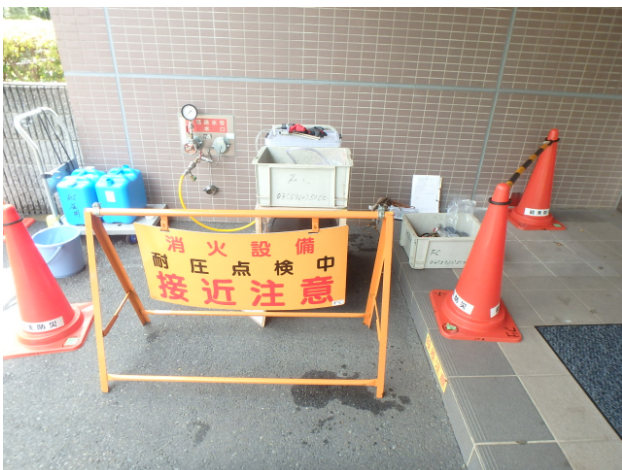
作業車が入れない現場はミニテスター
